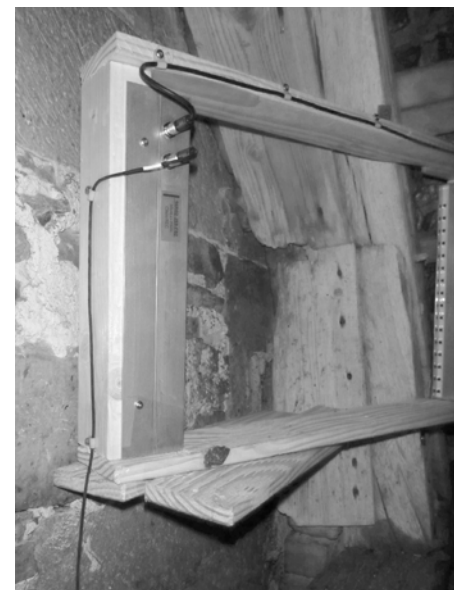
Das Einflugloch der Fledermäuse bekommt einen Rahmen, an den die Zählshranke montiert wird.
