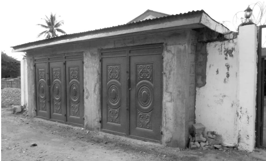
Die Arbeiten am neuen Showroom gehen voran.
