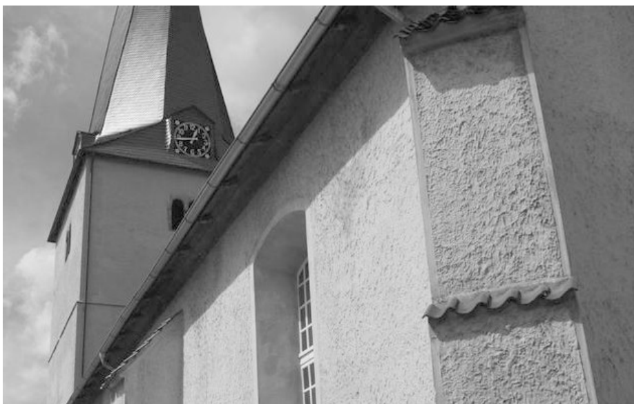
Im Herbst 2020 plant die Gemeinde, mit der Sanierung zu beginnen.
