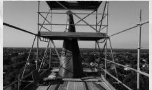
St. Johannis-Kirche: Rahdens höchste Baustelle
